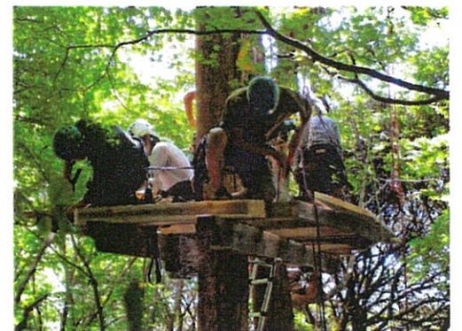
2段デッキ根太組み
