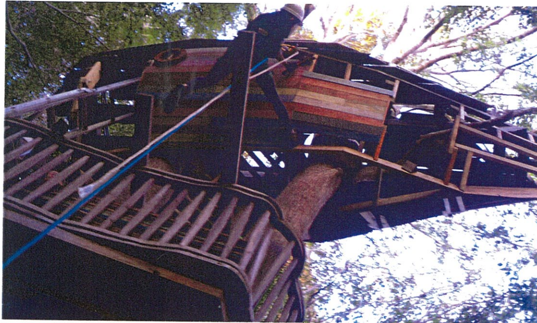
船体貼り作業の様子(ぶら下がっているのは女子大生)
